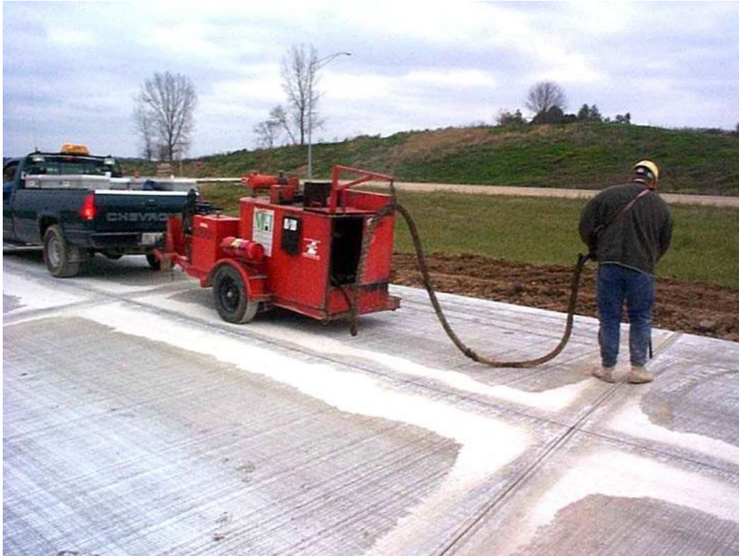
Installing hot pour sealant
