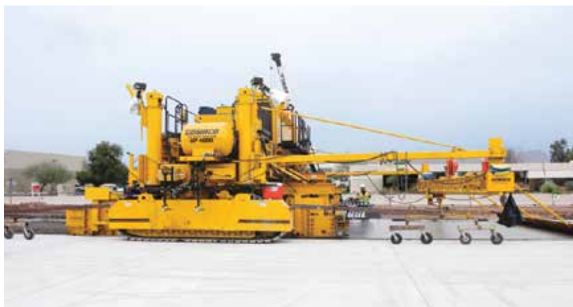
Figura 98. Control del perfil de pavimentación mediante una línea guía móvil sobre la pista adyacente (fuente: Kevin Klein, Gomaco)
