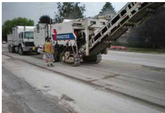
Figura 3. Fresando hormigón (izquierda) y superficie fresada (derecha)
