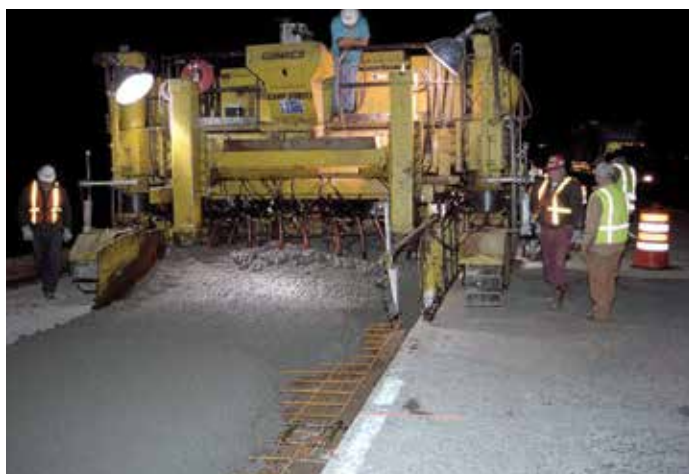
Figura 99. Control del perfil de pavimentación mediante un patín sobre la pista adyacente (fuente: Wouter Gulder, Southeast Chapter, ACPA)
