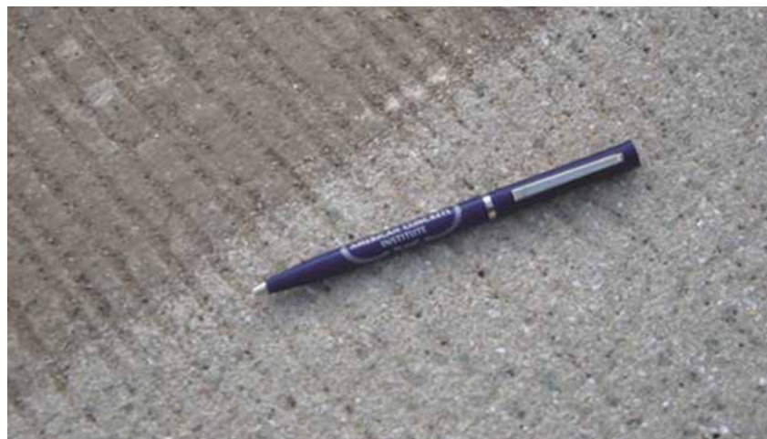
Figure 109. Compare la textura de la superficie de un área no granallada (mitad izquierda superior de la imagen) con la textura rugosa de la superficie en la sección granallada del pavimento (bajo el lápiz) (fuente: Leif Wathne, ACPA)
