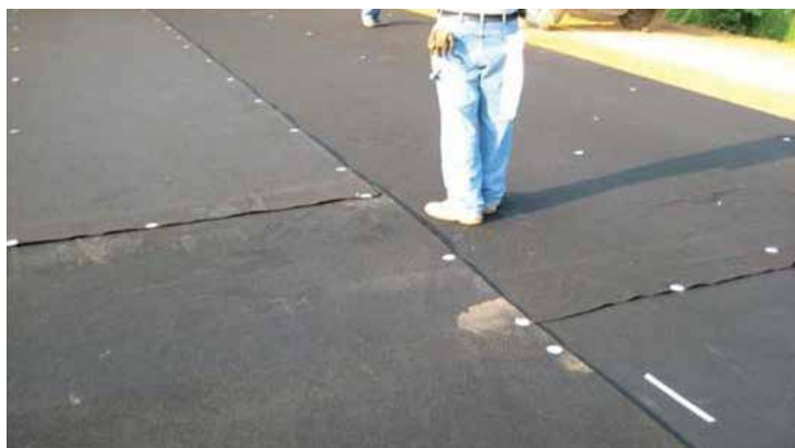
Figura 110. Traslape de geotextil no tejido
