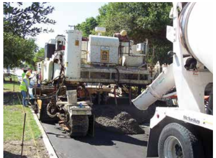
Figura 97. Pavimentadora típica de cuatro orugas, modificada a tres orugas permitiendo un espacio lateral cero en una situación con cuneta y solera (fuente: Jim Duit, Duit Construction Co, Inc.)
