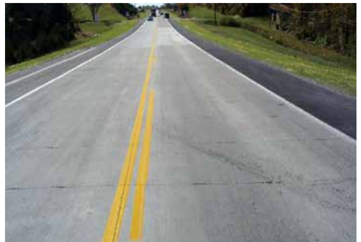
Figura 45. La Ruta D35 con un refuerzo no adherido de 125 mm (5 in.) (fuente: Todd La Torella, MO/KS Chapter, ACPA)
