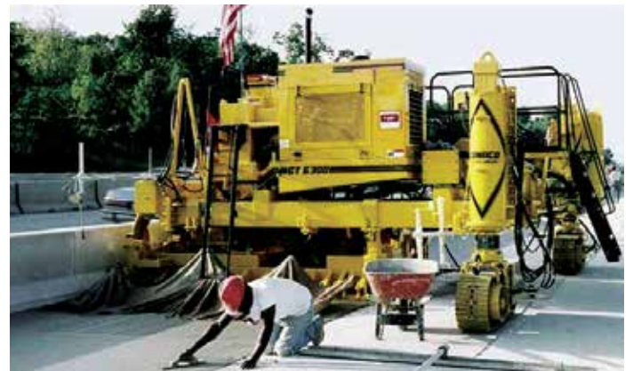
Figura 96. Pavimentadora de tres orugas, sin espacios laterales, colocando hormigón junto a la barrera de la mediana (fuente: Kevin Klein, Gomaco)
