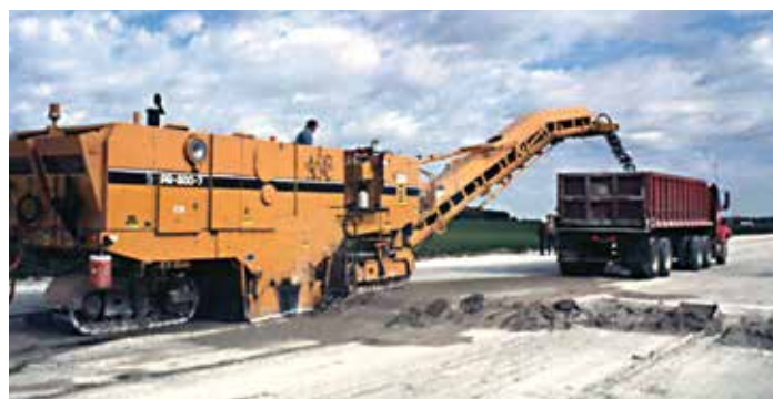
Figura 118. Típica operación de fresado de un pavimento de hormigón (fuente: Randell Riley, Illinois Chapter, ACPA)
