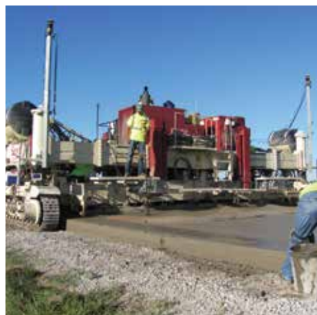
Figura 140. Sistema 2, equipo pavimentador
