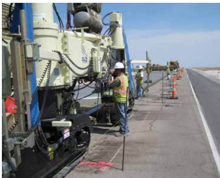
Figura 95. Pavimentadora con línea guía
