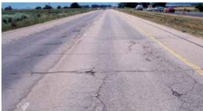
Figura 19. La Ruta SH-119 en 1991 antes de la colocación de un refuerzo con hormigón adherido (fuente: Ron Youngman, CO/WY Chapter, ACPA)
