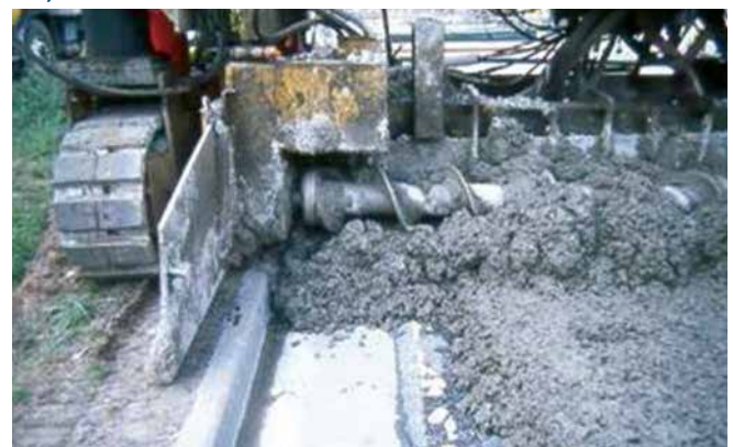
Figura 61. Hormigonado de cuneta recubierta (fuente: Jim Amundsen, Grace Construction Products)
