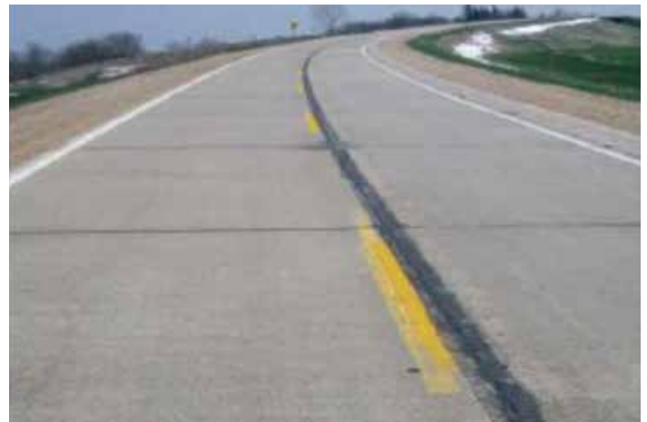
Figura 29. Refuerzo de hormigón adherido de 75 mm (3 in) (fotografía de 2013) (fuente: Todd Hanson, Iowa DOT)
