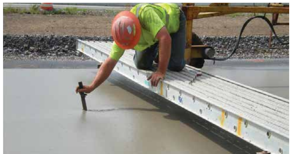
Figura 115. Verificación manual de la posición de las barras de traspaso de cargas
