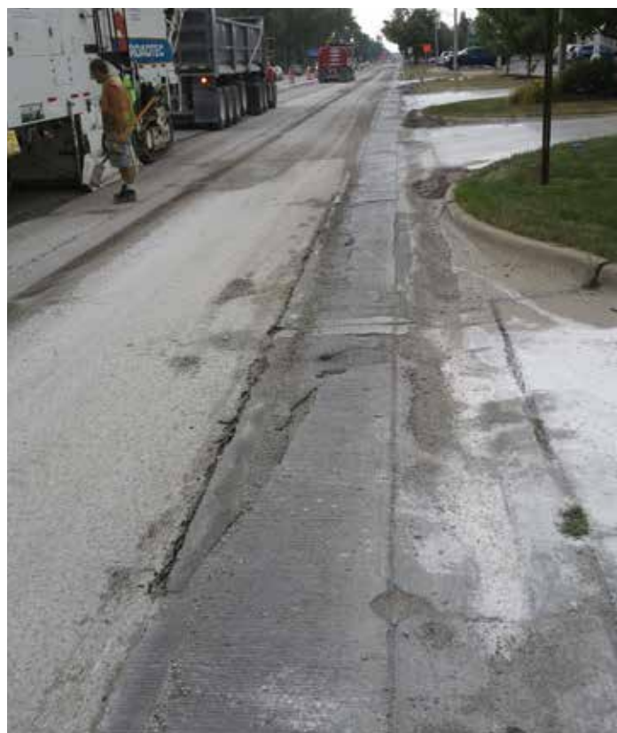
Figura 119. Típica operación de fresado de un pavimento de hormigón (fuente: Dan De Graaf, Michigan Concrete Paving Association)
