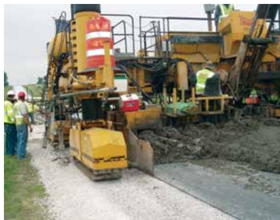
Figura 100. Pavimentadora sin línea guía (fuente: Jim Cable, Iowa State University)
