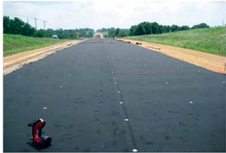
Figura 92. Capa separadora de geotextil (The Transtec Group (sin fecha))
