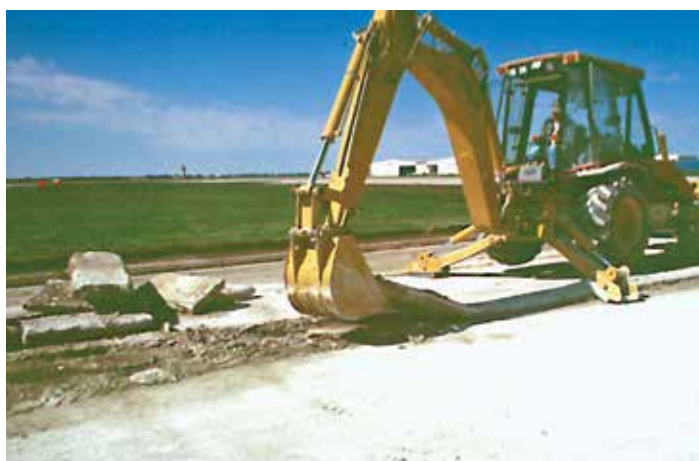
Figura 116. Remoción de losas de refuerzo (fuente: Randell Riley, Illinois Chapter, ACPA)
