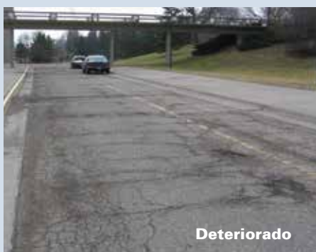
Figura 7. Proceso de evaluación del pavimento con ejemplos de pavimentos existentes en diferentes condiciones (fuente: Snyder & Associates, Inc.)
