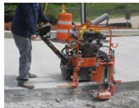
Figura 69. Formación de ranuras para instalar placas transferencia de cargas ovaladas (fuente: Nigel Parkes, PNA Construction Technology)
