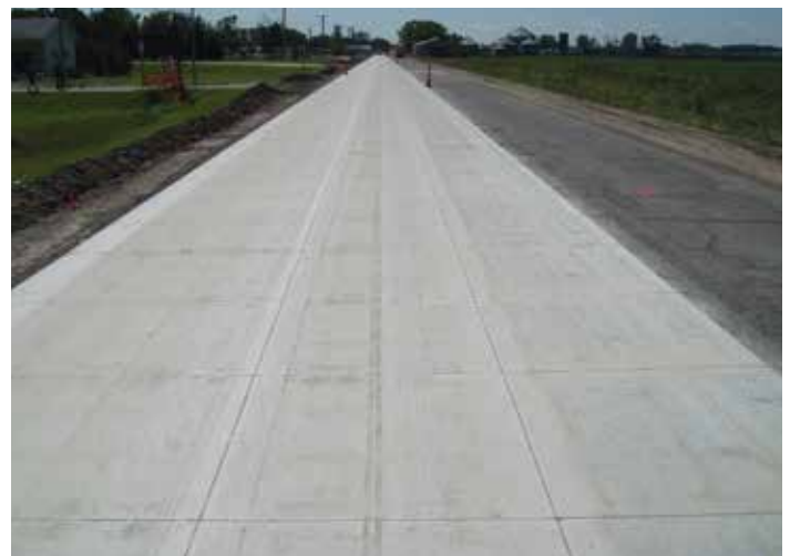
Figura 25. Capa de refuerzo adherida al pavimento compuesto (fuente: James Cable, Iowa State University)
