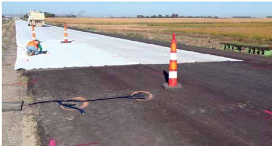
Figura 93. Tela geotextil de color claro utilizada como capa separadora para un refuerzo no adherido
