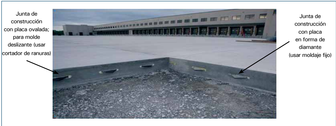
Figura 65. Placas de transferencia de cargas en forma de diamante para construcción con molde fijo (lado derecho) y placas de transferencia de cargas ovaladas para molde deslizante
