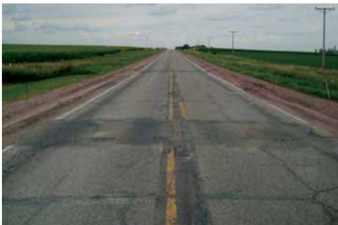
Figura 39. Pavimento compuesto antes de colocar una capa de refuerzo de hormigón no adherida
