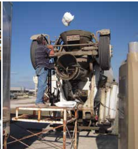
Figura 124. Adición de fibras en la planta (izquierda) y con bolsas vaciadas dentro de un camión betonera (derecha) (fuente: Randell Riley, Illinois Chapter, ACPA)
