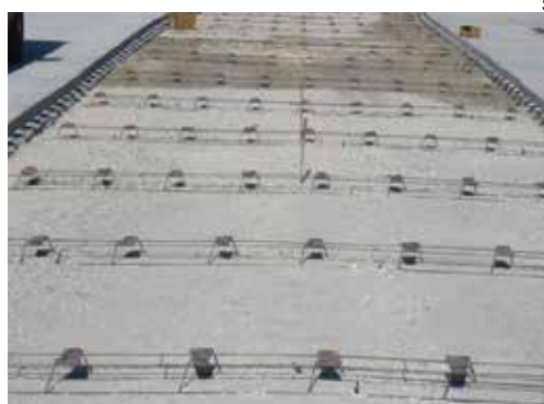
Figura 54. Canastos con placas de transferencia de cargas ahusadas en juntas transversales y placas ovaladas en juntas de construcción longitudinales formadas con molde deslizante
