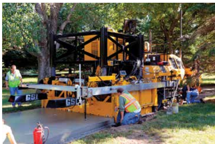
Figura 101. Pavimentadora sin línea guía y sin espacio lateral (fuente: Gomaco)
