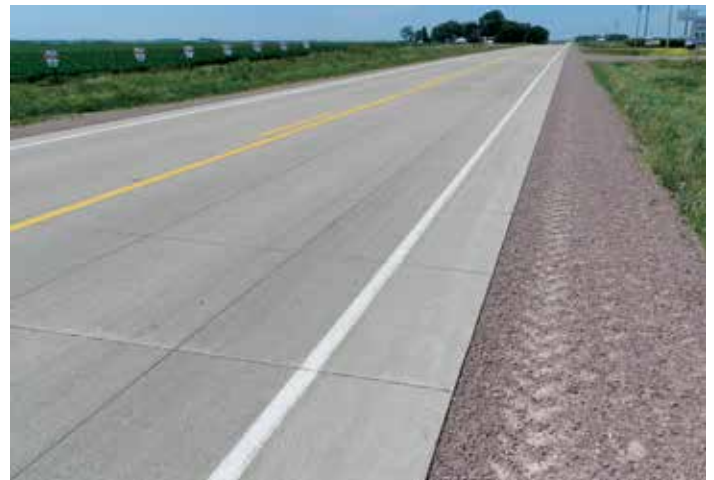
Figura 35. Pavimento asfáltico en estado entre pobre y deteriorado reforzado con hormigón no adherido (fuente: Kevin Merryman, Iowa DOT)
