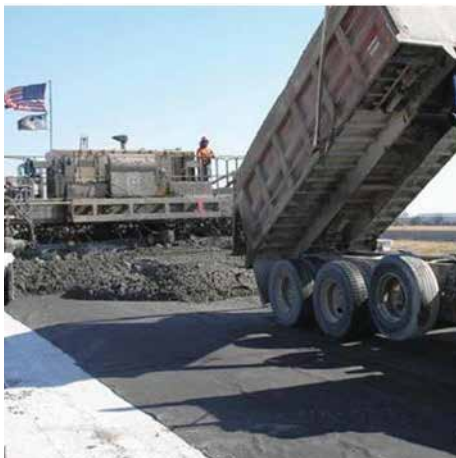
Figura 112. Pavimentando sobre un geotextil no tejido
