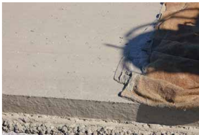
Figura 125. Refuerzo con hormigón con fibras sintéticas terminado
