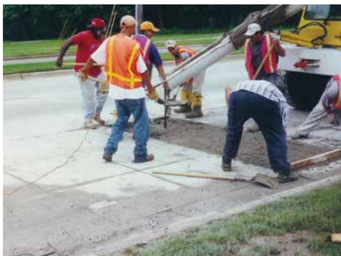
Figura 117. Terminación y curado de la Reparación de una capa de refuerzo de hormigón (fuente: Dan De Graaf, Michigan Concrete Paving Association)
