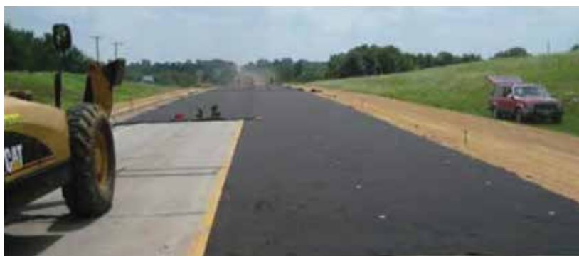
Figura 50. Capa separadora de tela geotextil (fuente: Missouri DOT)
