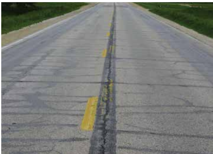
Figura 24. Pavimento compuesto existente (fuente: James Cable, Iowa State University)
