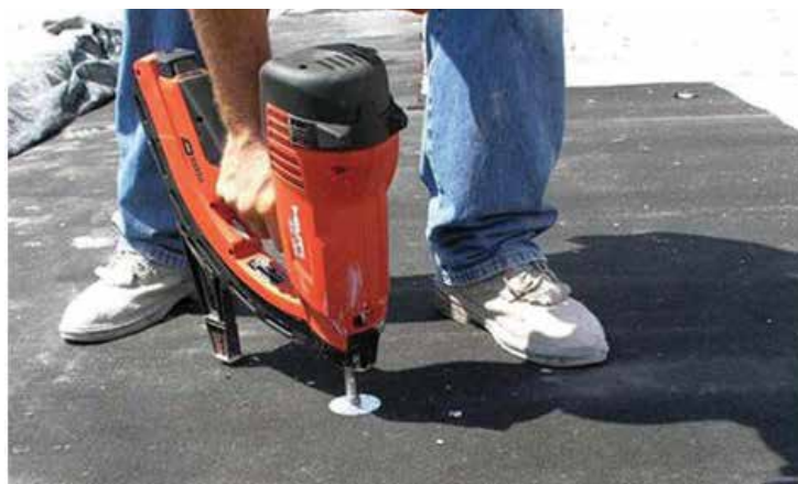
Figura 111. Anclando tela geotextil no tejida a un pavimento de hormigón existente
