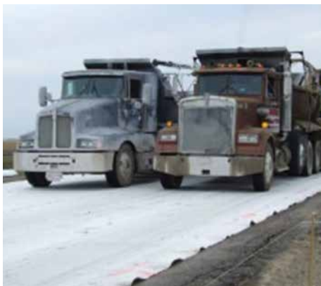
Figura 113. Pavimentando sobre una capa separadora de geotextil blanco (fuente: Larry Engbrecht, South Dakota Chapter, ACPA)
